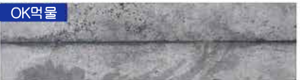
콘크리트 타설 후의 먹 매김 작업
